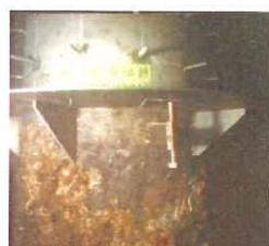
鋼管杭の補強（水中スタッド溶接状況）
