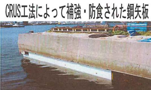
CRUS工法によって補強・防食された鋼矢板
