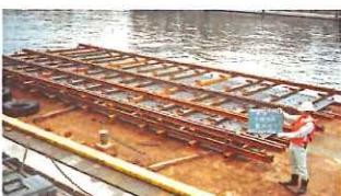
鋼製型枠の組み立て
